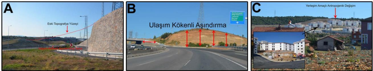
Fotoğraf 6: A) ve B) D-100, Tem ve Kuzey Marmara Otoyolu Bağlantısı İçin Rölyefin Değiştirilmesi, C) Dilovası Köşeler Mahallesi Yeni Yerleşim Amacıyla Rölyefin Düzenlenmesi
