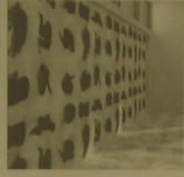
Resim 9. "Çıplak", seramik duvar kaplaması
