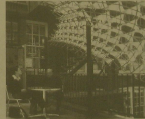
Resim 3. Güneş Işığı, Rüzgar ve Yağış Analizlerine Göre Şekillenmiş Parçalı Membran Strüktürü
