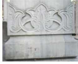
Fot. 15. Yan cephe taş bölümü.
