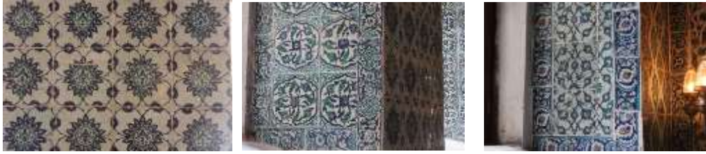
6-8: Okuma Odası Pencere ve kapı arasındaki duvar yüzeylerinde kullanılan ulama çiniler.
